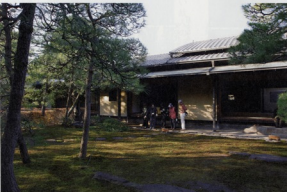
成城丁宿務野島屋(成城5-12-19)昭和42年(1967)竣工。 木造平屋。吉田五十八設計。裏面建といわれる近代数寄屋様の様相と裏面でつながり草葺があり、スギゴケの庭が美しい。
